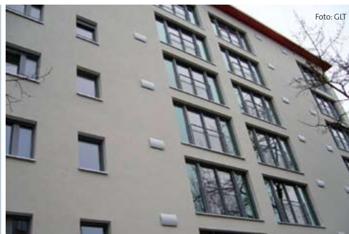
Bild 3: Bei den Außenblenden verhindert ein integrierter Trennsteg den Kurzschluss zwischen Zu- und Abluft; farblich lassen sie sich an die Hausfassade anpassen
